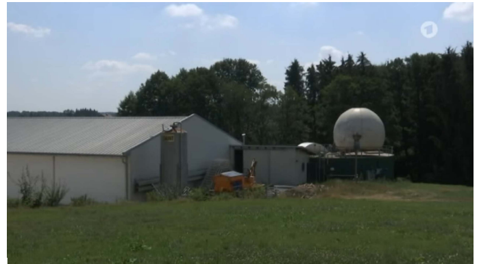
Biogasanlagen brauchen Auffangbecken, um Gewässer vor langfristigen Schäden mit Todesfolge für Pflanzen und Tiere zu schützen [1]
