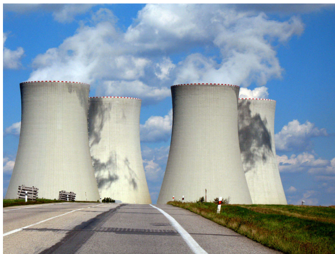
15 statt ein Mitarbeiter werden benötigt, um die gleiche Menge Fakepower zu erzeugen im Vergleich zu Braunkohlestrom. [1]
